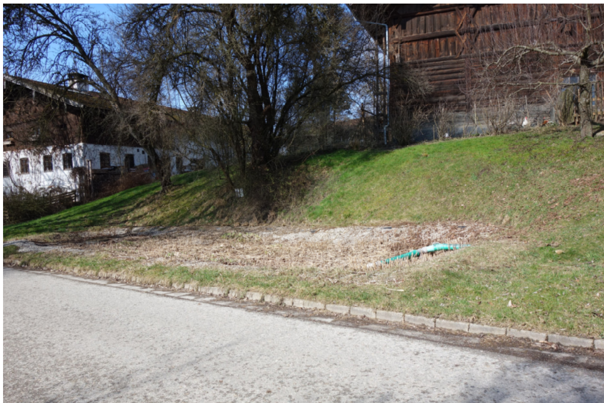
Rückhaltebecken im Ort
